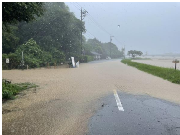
2022年(令和4年)8月の大雨による 日野川の越水(日野川河川緑地右岸側)
