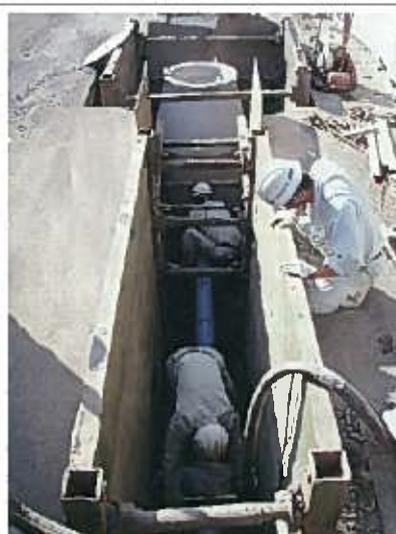
汚水管渠の敷設工事の様子
