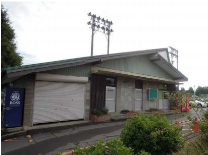
管理施設(管理棟)
