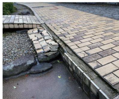
周縁部のタイルの破損、剥がれ植樹樹の破損が複数箇所確認できる。
