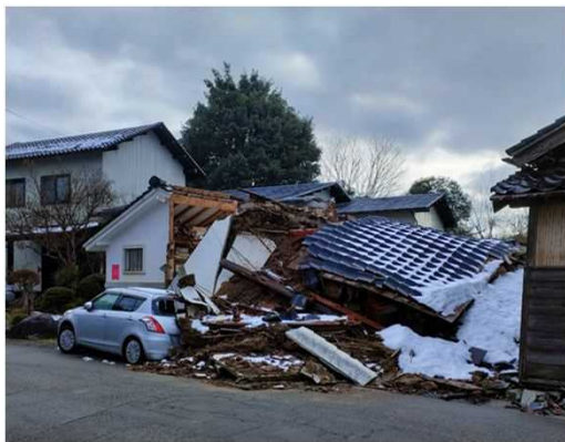
<能登半島地震で倒壊した木造住宅>
