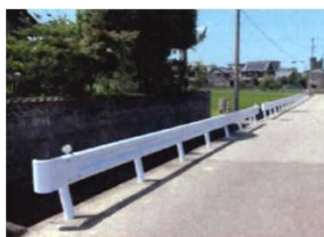
ガードレール設置
