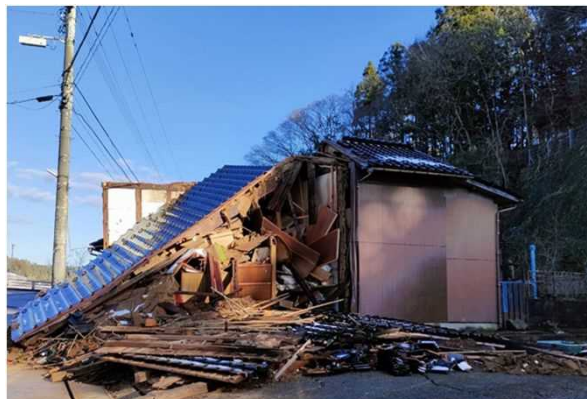
<能登半島地震で倒壊した木造住宅>
