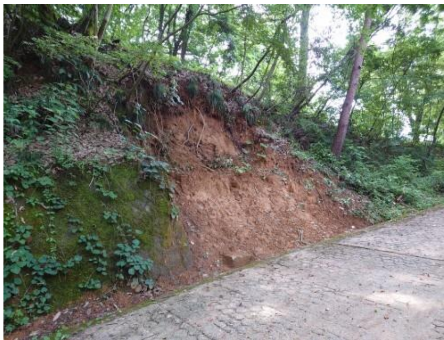
▲被災箇所②
