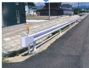
ガードレール設置
