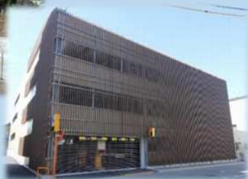
▲市立体駐車場へ設置
