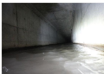
▲管路内の様子
