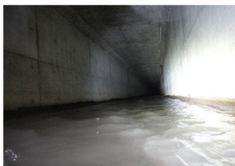
▲管路内の様子
