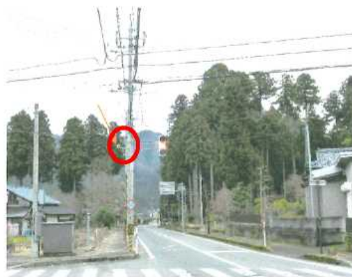
【防犯カメラ設置例】
