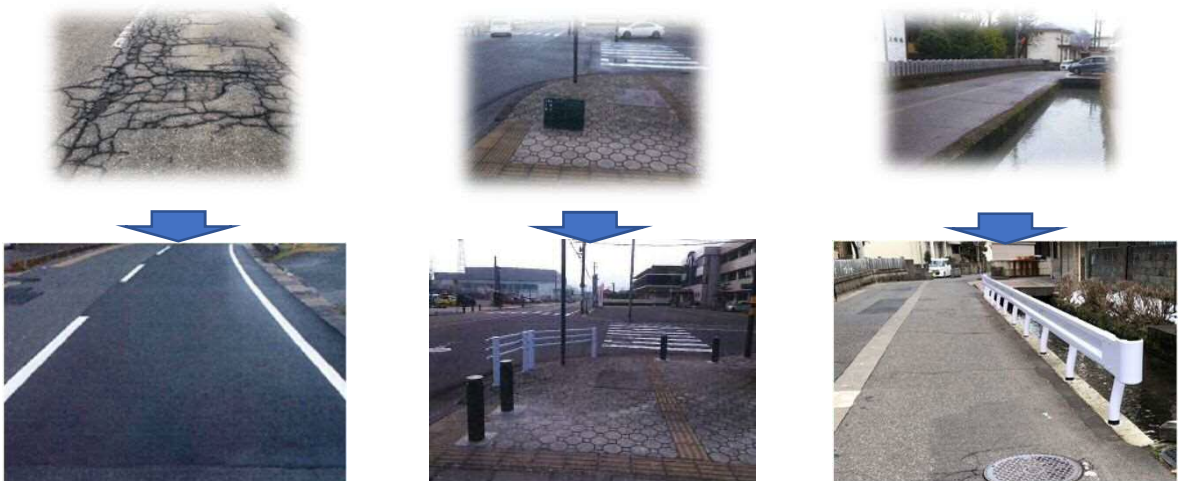
傷んだ舗装面の改修
