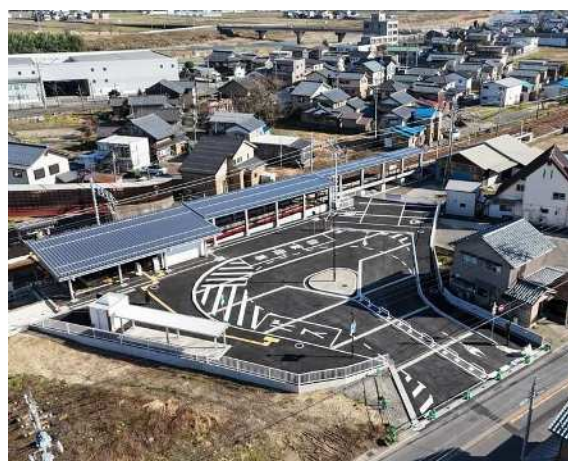
しきぶ駅、駅前広場全景
