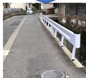
ガードレール設置
