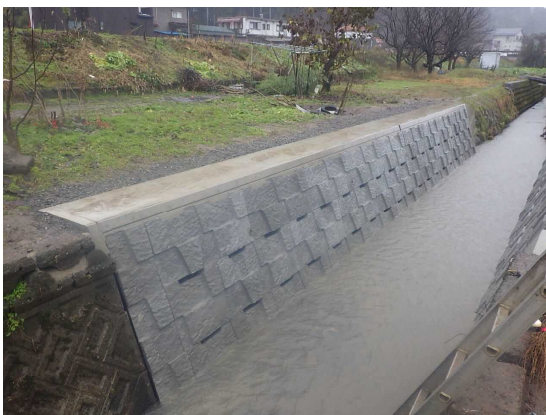
河川改修（護岸の補強）
