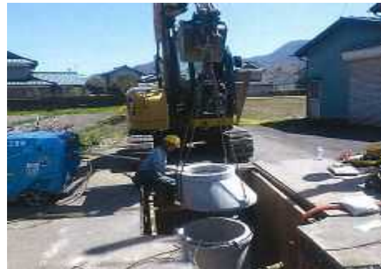
下水道の整備工事の様子
