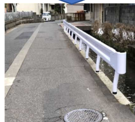
ガードレール設置
