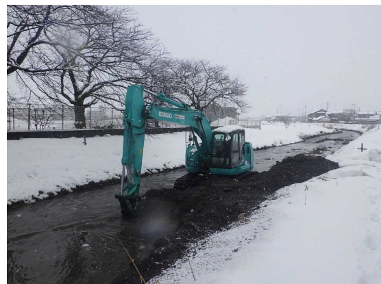
浚渫（堆積土砂の撤去）
