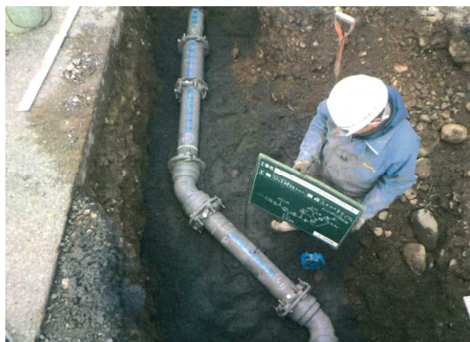
水道管の耐震化工事の様子
