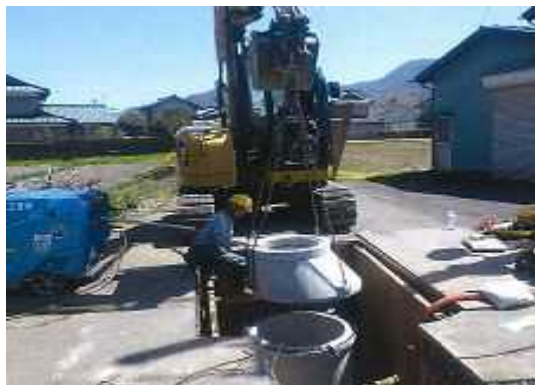
下水道の整備工事の様子
