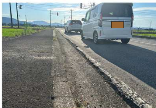
路肩部舗装の欠損解消
