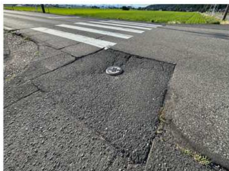
つぎはぎ舗装による凹凸の解消
