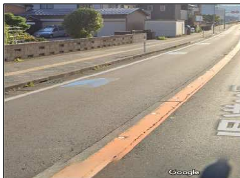
自転車通行位置を明確化させる路面標示の例
