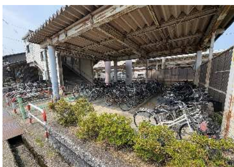
ハピラインふくい武生駅東駐輪場
