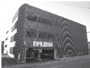
▲立体駐車場が完成
