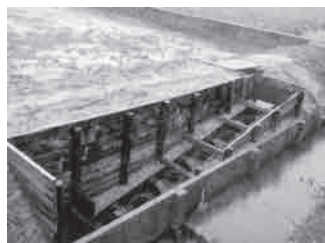
▲設置した水田魚道
