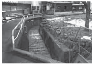
岡本川改修工事
