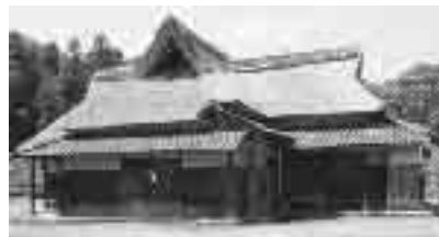
屋根を葺き替えた旧谷口家
