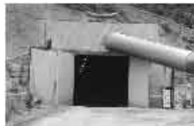
笠倉トンネルの工事現場
