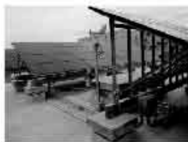
越前市中央図書館電気工事(当社施工) 国土建設電気工事株式会社
