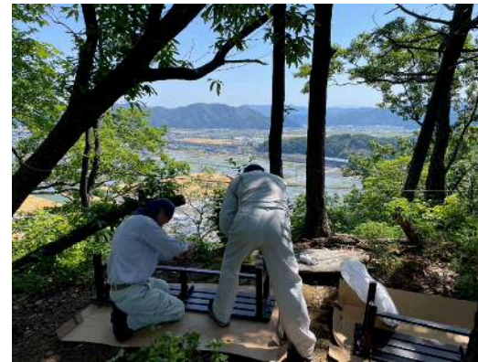
▲ベンチ設置作業
