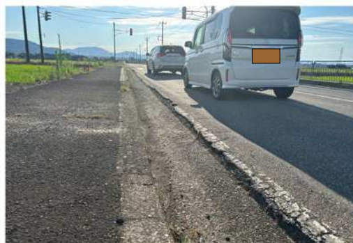
路肩部舗装の欠損解消
