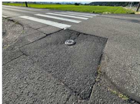
つぎはぎ舗装による凹凸の解消
