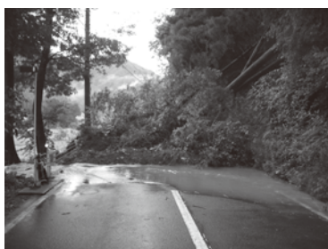
大きな被害を受けた南坂下町 国道417号の土砂崩れ
