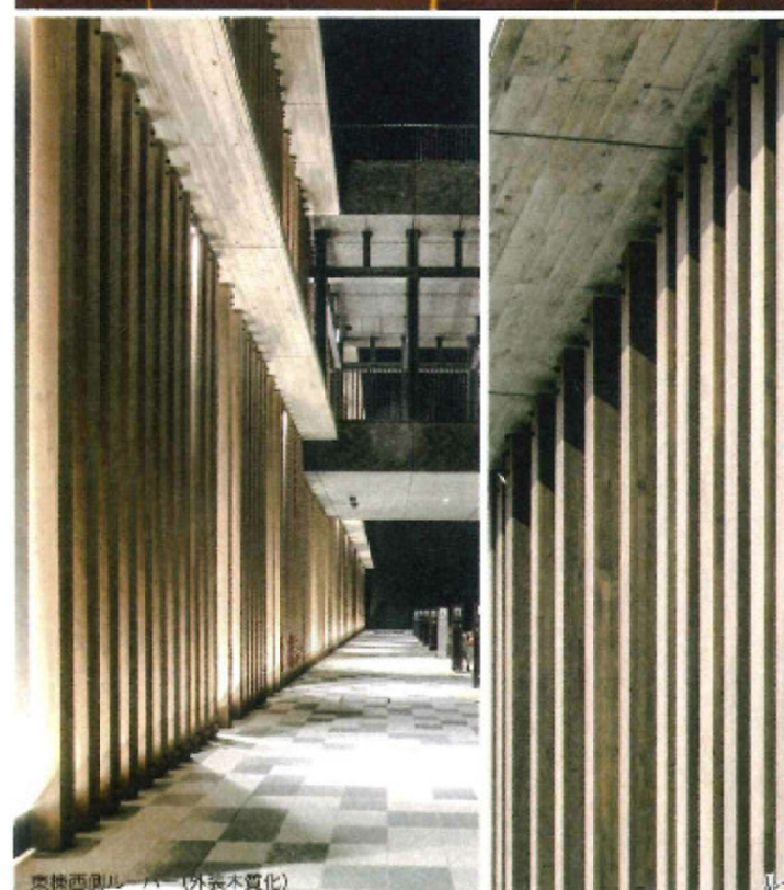
東側西側ルーバー(外装木質化)
