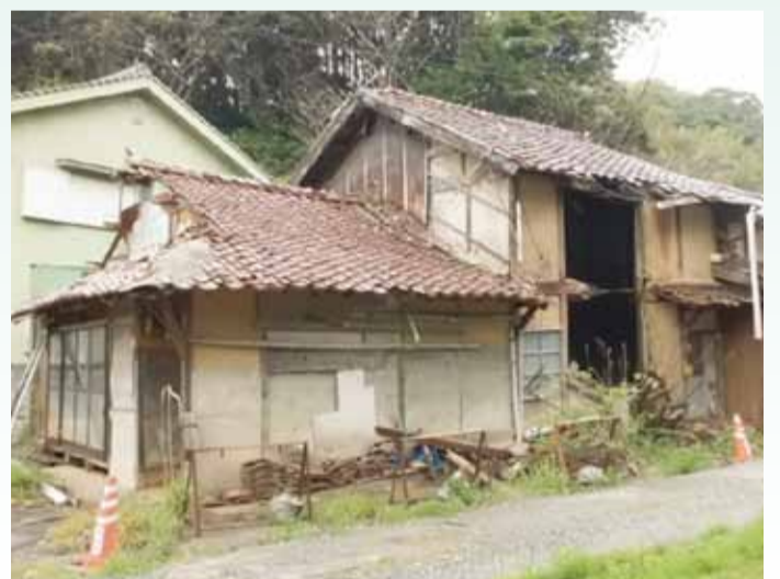
放置されている空き家
