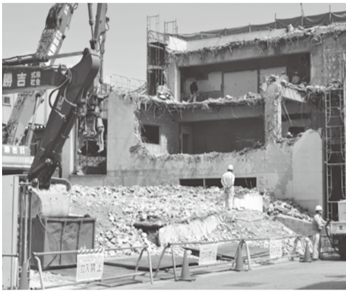
解体作業中の市役所第2庁舎、第3庁舎 (立体駐車場建設予定地)
