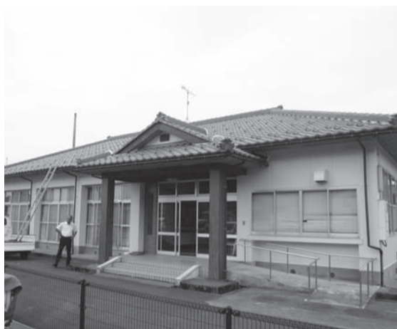
新堂集落センターの大規模修繕工事
