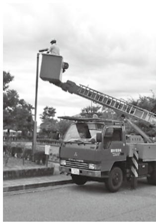
市内街路灯の点検状況
