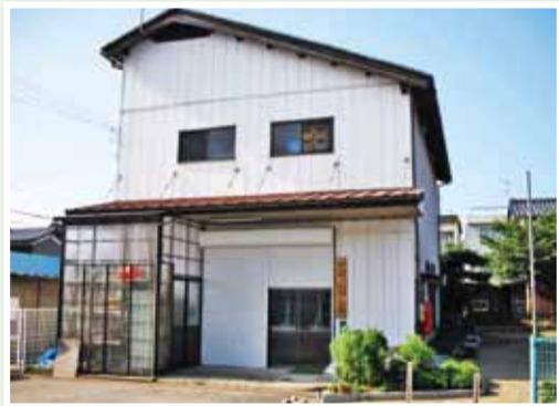
耐震補強される堀川町ふれあい会館
