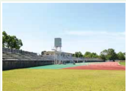
武生東運動公園陸上競技場内の写真判定装置塔(写真中央)
