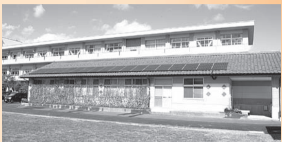
太陽光パネル設置(武生第六中学校)
