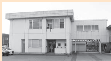
民間委託される村国浄水場
