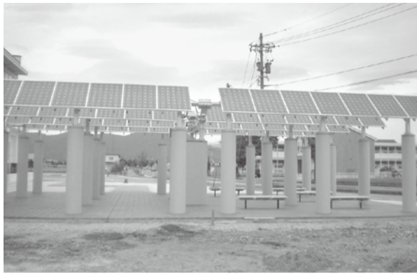
瓜生水と緑公園の太陽光発電設備
