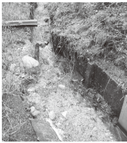
老朽化した破損水路（下黒川町地係）
