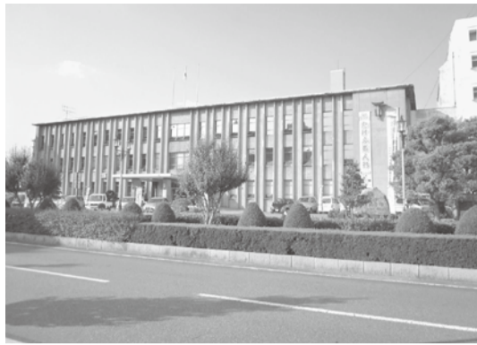
越前市役所 本庁舎
