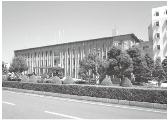
越前市役所 本庁舎
