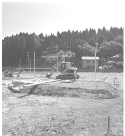
コウノトリのケージの工事現場
