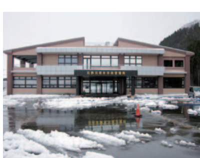
日野川用水中央管理棟
