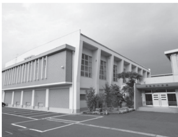
東側擁壁の工事を行う武生東小学校
