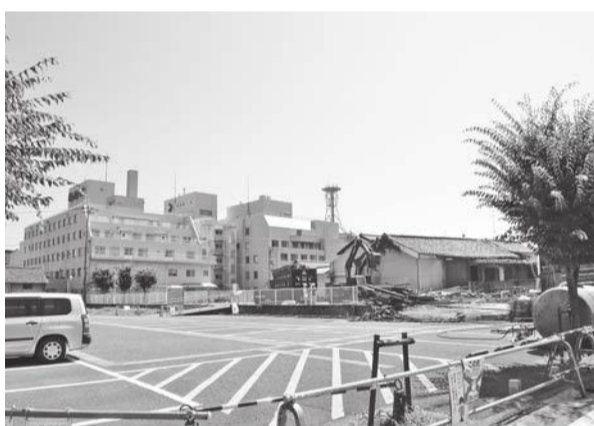
林病院の建設予定地では建物の解体が行われている (奥は現在の林病院)
