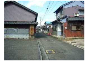
【老朽建物の解体により敷地を確保(例)】
