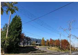
配置の工夫等により地域に開放された豊かな緑を持つ生産施設 (I&M・テクニク(和泉市))
