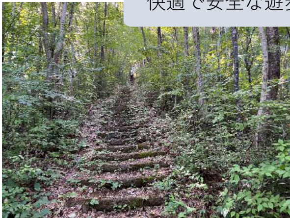
老朽化した階段の改修
