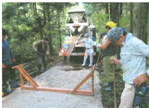
集落による林道維持活動（舗装施工）
