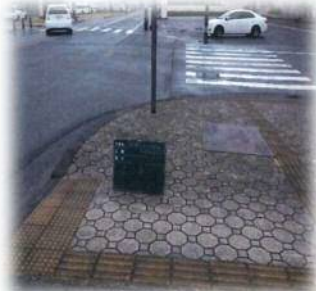
車止めの設置
