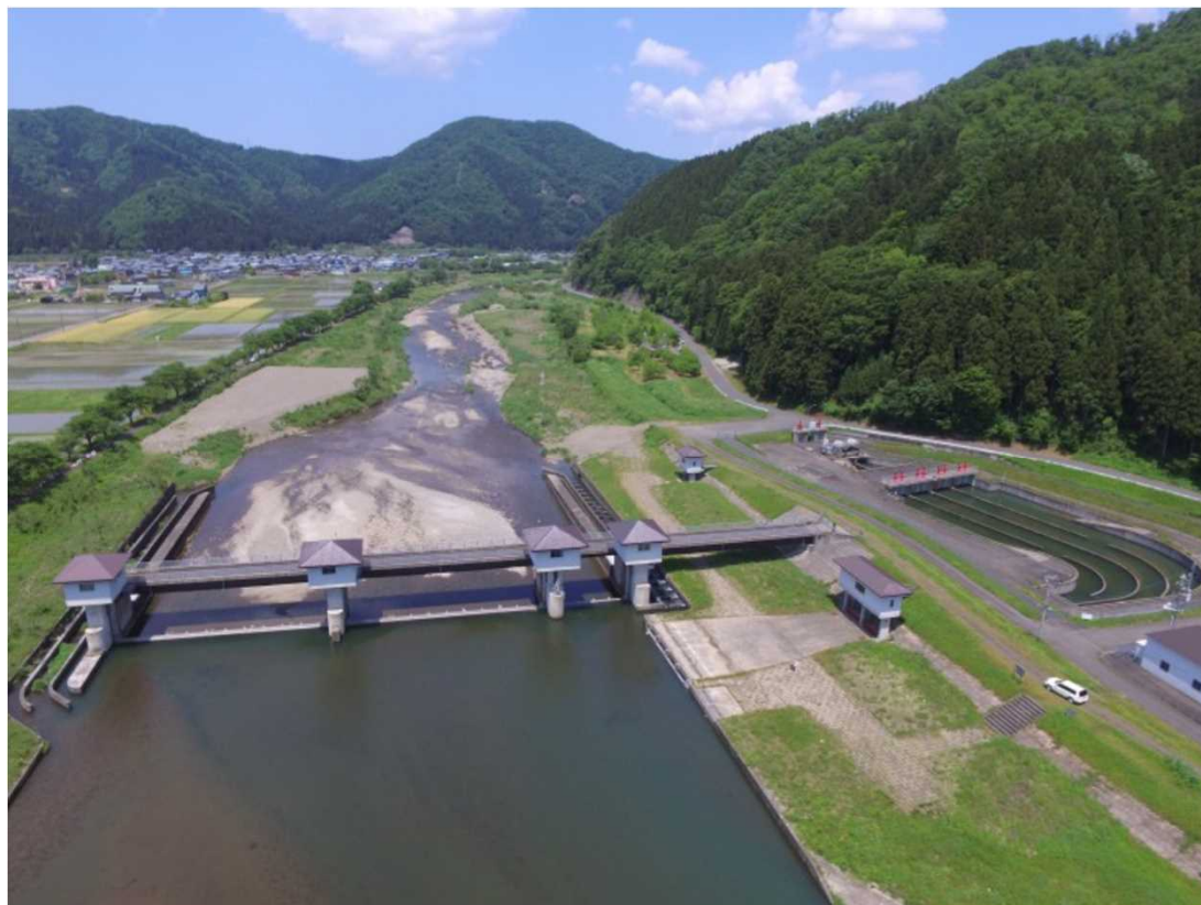
(八乙女頭首工)
