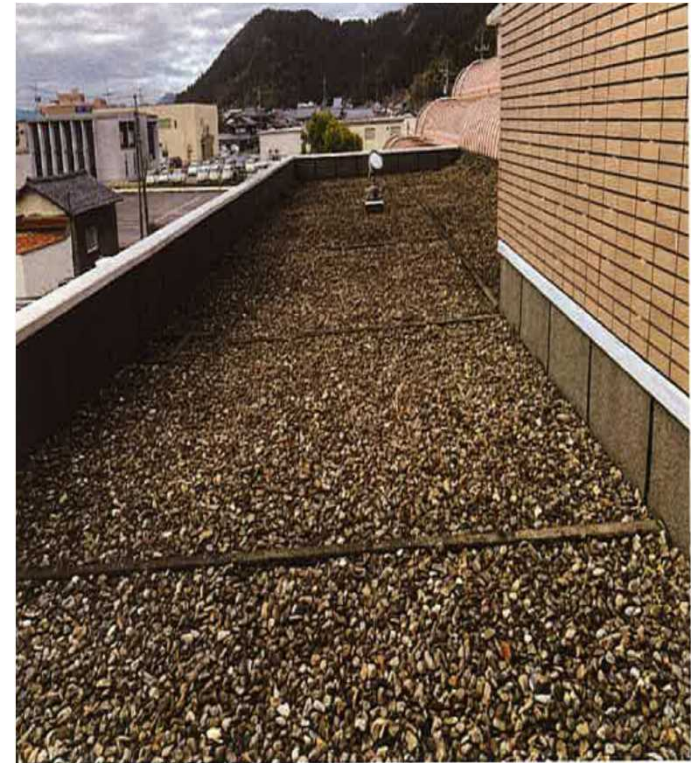
（屋上の防水工事）
