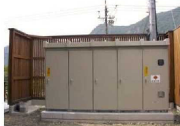
非常用発電機
