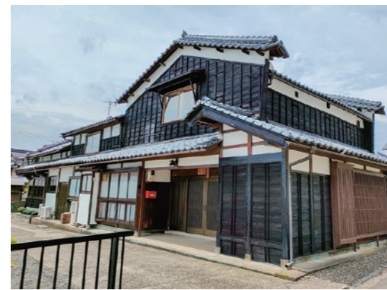
K様邸（新在家町）明治12年建築、平成30年改修
